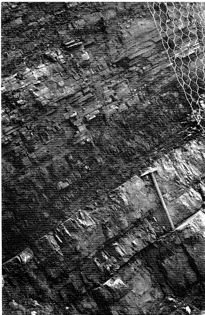
fig. 1 — Alternanza di dolomie in strati e banchi e di dolomie straterellate e lastroidi nel taglio del raccordo autostradale per l'uscita Lagonegro nord presso il viadotto della Malamugliera.
