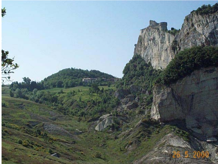
Fig. 18 - Frane per crollo e ribaltamento nelle pareti rocciose sottostanti l'abitato di San Leo.
