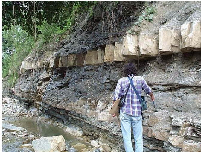
Fig. 10 - Alternanze di calcilutiti, calcareniti, marne ed argilliti della Formazione di Sillano. Fiume del Rio ad est di San Leo.
